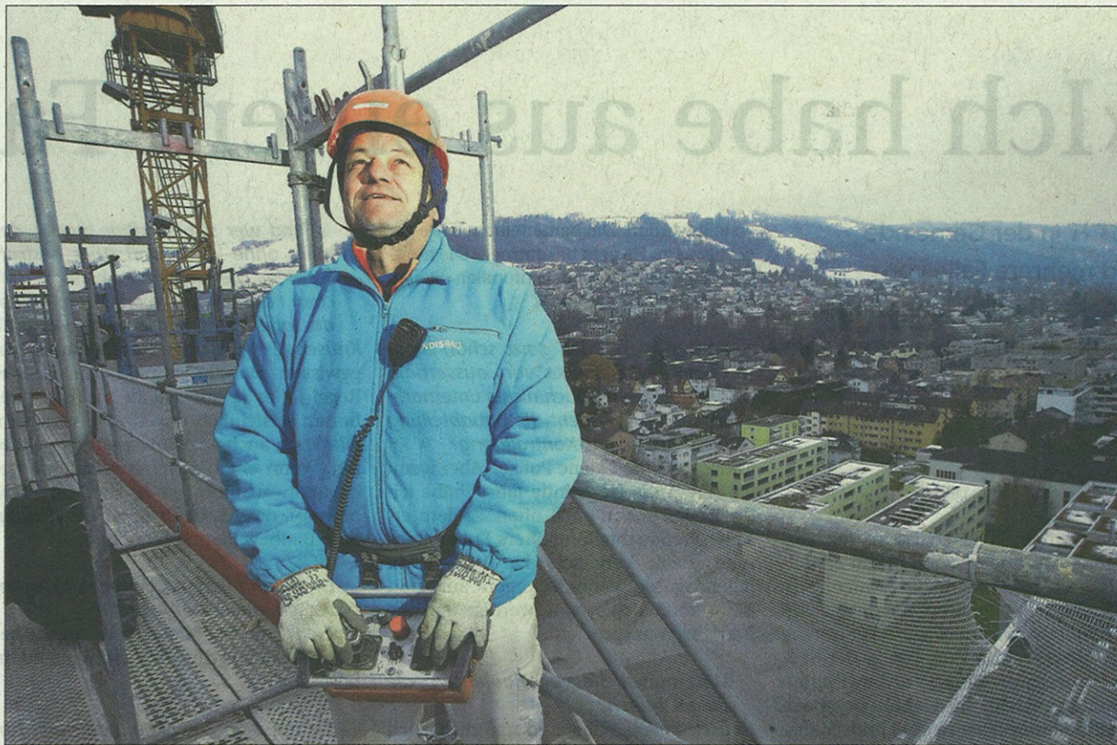
Das Hochhaus des Obstverbands an der Baarerstrasse nimmt Formen an. Im Bild: Kranführer Osman Ramic bei der Arbeit.
